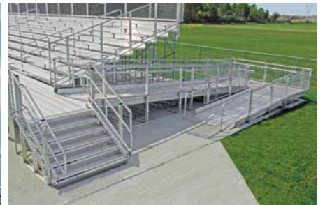
ADA ACCESSIBLE RAMP
